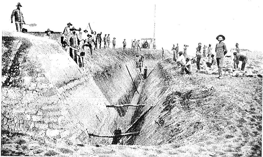
Photo 2: “Trabalhos de fortificação no pôsto militar do Cuangar” (“Fortification work on the Cuangar military post”). (João de Almeida, Sul d'Angola. Relatório de um Governo de Distrito (1908-1910) , Divisão de Publicações e Biblioteca Agência Geral das Colónias, Lisboa, 1912: 185)
